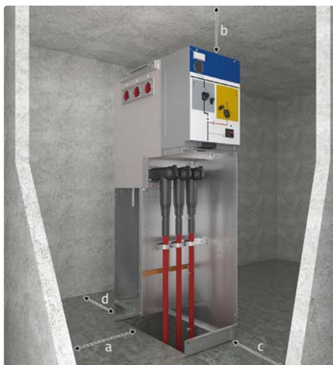
Distances minimales d'installation [mm] (pieds/pouces)
